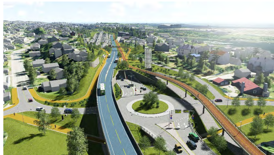
Figur 22: Reguleringsforslagets løsning: Vestre portal Strandlokket med bussveg og gang-/sykkelsystem som møtes oppå lokket, mens lokalveg føres fra portal inn i rundkjøring. Transparent lufttårn for Bærumsdiagonalen til høyre for portal.
