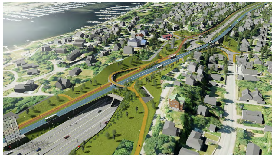
Figur 26: Reguleringsforslagets løsning. Illustrasjon av miljølokket på Strand
