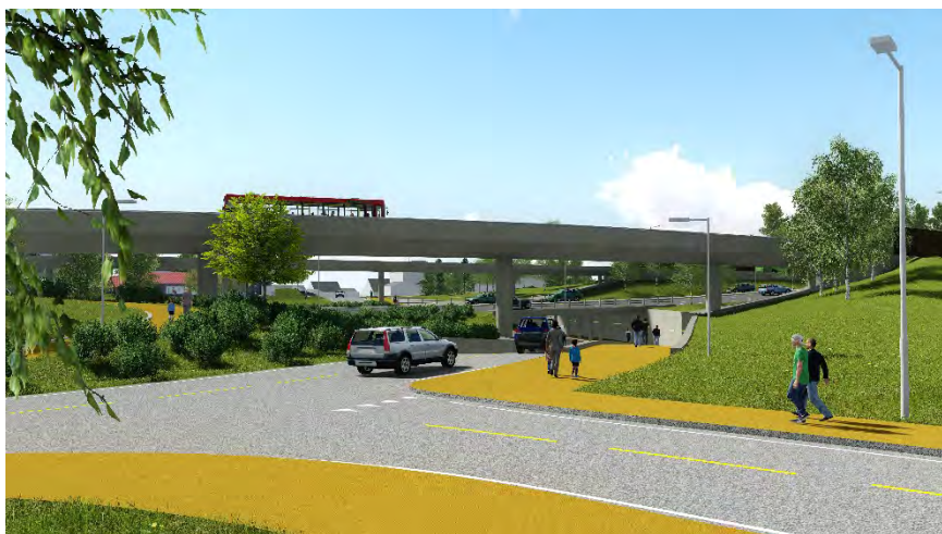
Figur 29: Strandkrysset sett sørover fra Markalléen i etappe 1. Michelets vei føres under E18/fremtidig lokalveg. Når neste etappe bygges, flyttes E18 ned i Høviktunnelen. Deretter flyttes Michelets vei opp fra undergangen og føres gjennom rundkjøringen i krysset med lokalvegen.
