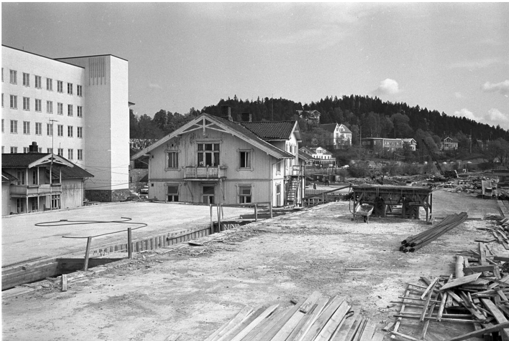
Bygging av ny E18 i 1960-årene
