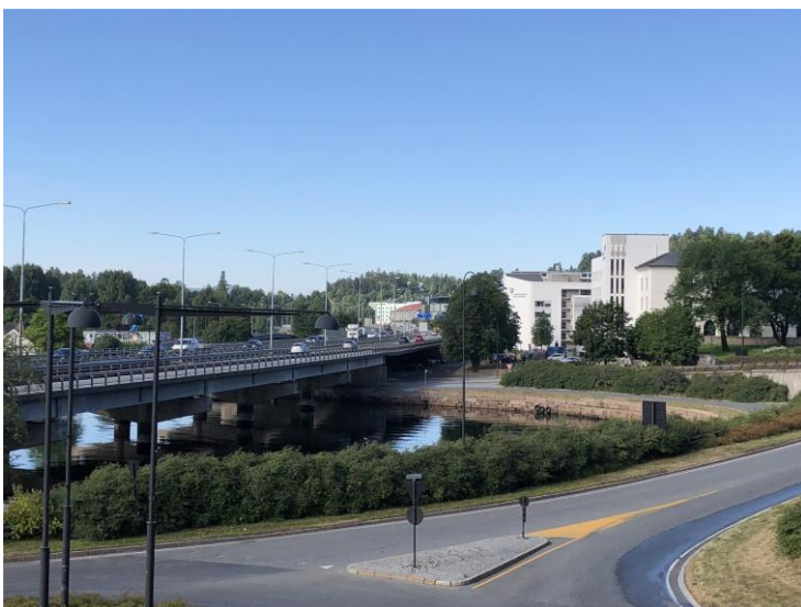
E18 går som viadukt over Sandviksbukta.
